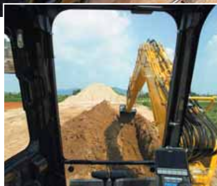
Großzügige Verglasung für hervorragende Rundumsicht
