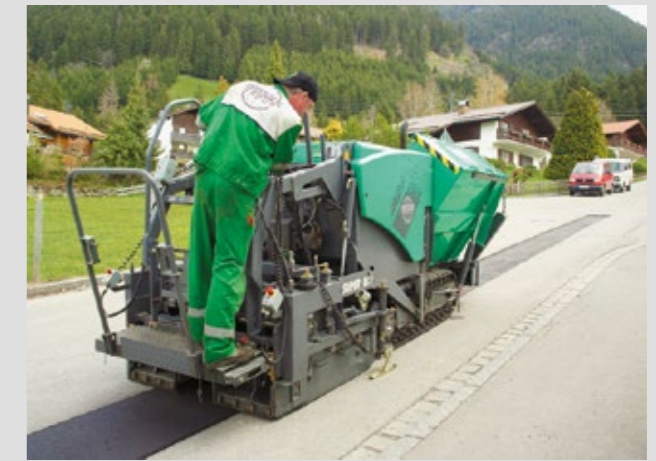
Befüllen von Kanalgräben
