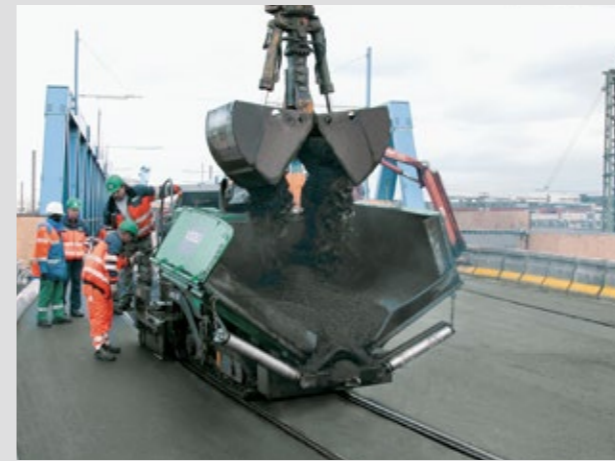
Asphalteinbau zwischen Straßenbahnschienen
