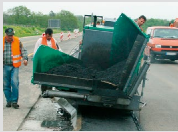
Mittelstreifenbefestigung auf Autobahnen
