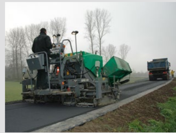
Asphalteinbau auf Dämmen
