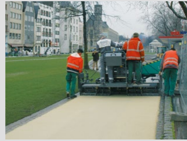
Wegebau in Parkanlagen
