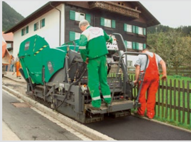
Erneuerung von Fußgänger- und Radfahrwegen
