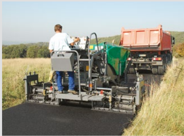
Bau von Wirtschaftswegen
