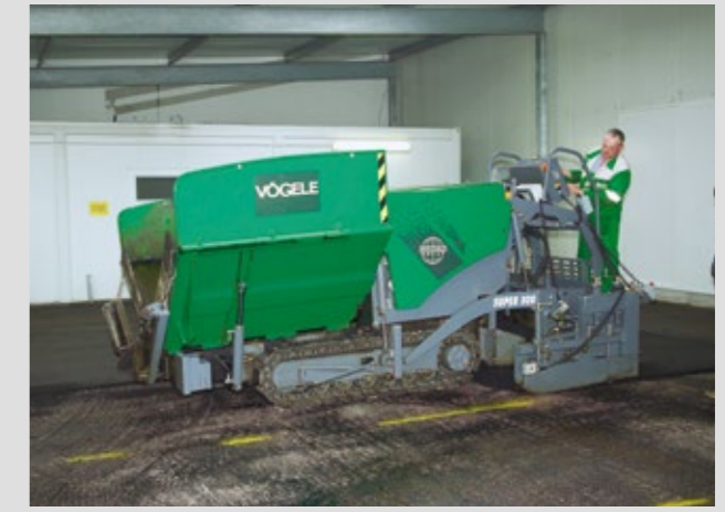
Asphalteinbau in Industriehallen
