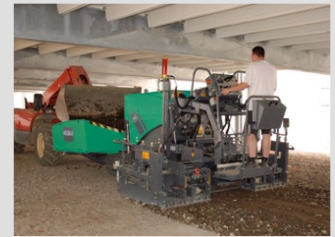
Herstellung des Unterbaus für Pflastersteine
